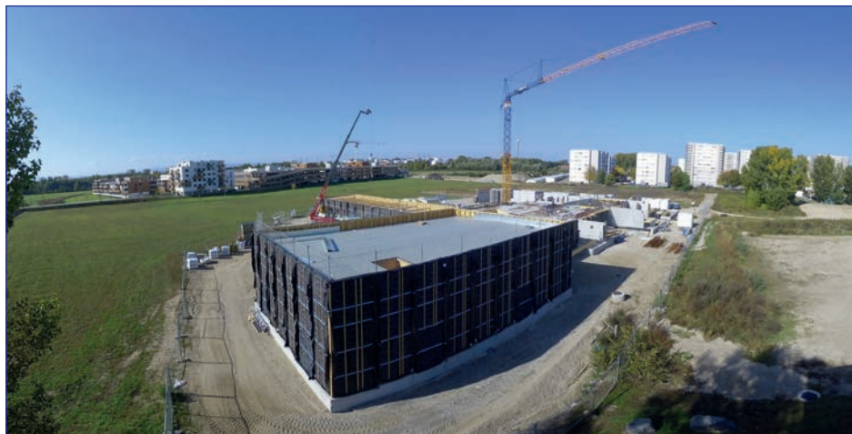
Photo du chantier prise depuis le toit du Point d'Eau.
