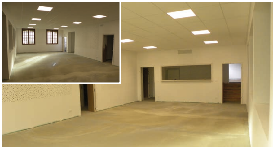
Nouvel aménagement intérieur au Hussard
