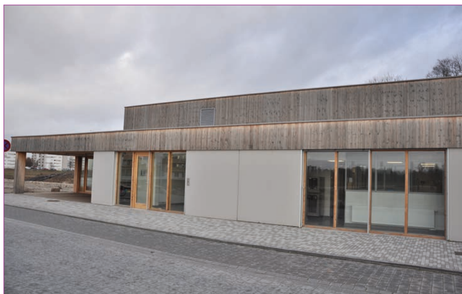
La cuisine centrale, située dans les locaux de la crèche du Bohrie, assure la préparation des repas de toutes les structures proposant une restauration collective.
